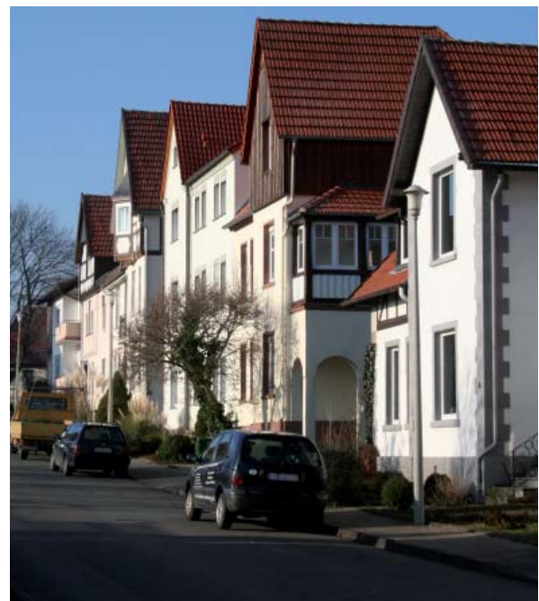
Bild 1 Durch die schrittweise Einführung des Energiepasses für Bestandsgebäude soll die energetische Sanierung von älteren Wohn- und Nichtwohn-Immobilien vorangetrieben und ihr CO 2 - Ausstoß gesenkt werden.
