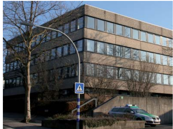
Bild 4 Öffentliche Gebäude, wie z.B. Schulen und stark frequentierte Ämter, müssen künftig den Energieausweis an einer für Besucher gut sichtbaren Stelle anbringen.
