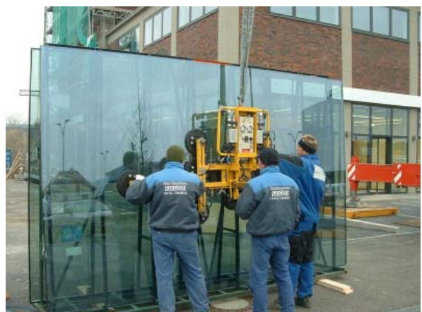
Bild 17 Beim Handling und bei der Montage von Gläsern mit Titandioxid-Beschichtung dürfen keine silikonhaltigen Saugplatten, Dichtungen oder Dichtstoffe eingesetzt werden. Gelangen Silikonöle auf die Oberflächen, beeinträchtigen sie den Selbstreinigungseffekt.
