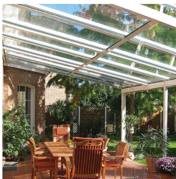
Bild 1 und 2 Fassaden- und Dachverglasungen müssen regelmäßig gesäubert werden. Selbstreinigende Gläser bleiben länger sauber und verlängern die Reinigungsintervalle.
