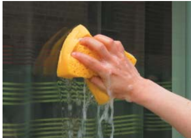
Bild 19, 20 und 21 Bei der Reinigung von Gläsern mit fotokatalytischer Beschichtung auf der Außenseite dürfen keine scheuernden oder kratzenden Hilfsmittel eingesetzt werden. Klares Wasser und einen Schwamm bzw. ein weiches Tuch und handelsübliche neutrale Glasreinigungsmittel empfehlen die Hersteller.
