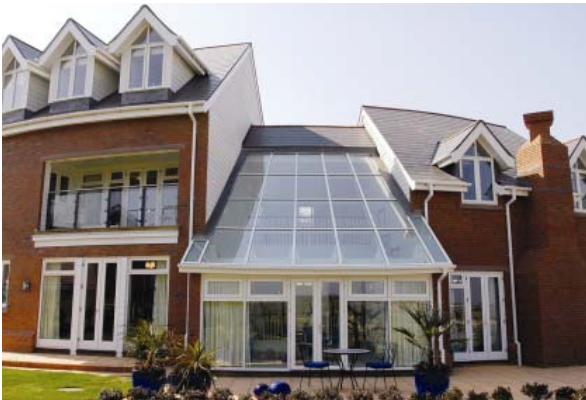
Bild 14 und 15 Dachverglasungen mit ausreichender Neigung bieten gute Bedingungen für selbstreinigende Gläser.
