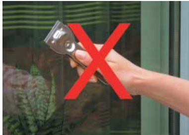
Bild 19, 20 und 21 Bei der Reinigung von Gläsern mit fotokatalytischer Beschichtung auf der Außenseite dürfen keine scheuernden oder kratzenden Hilfsmittel eingesetzt werden. Klares Wasser und einen Schwamm bzw. ein weiches Tuch und handelsübliche neutrale Glasreinigungsmittel empfehlen die Hersteller.
