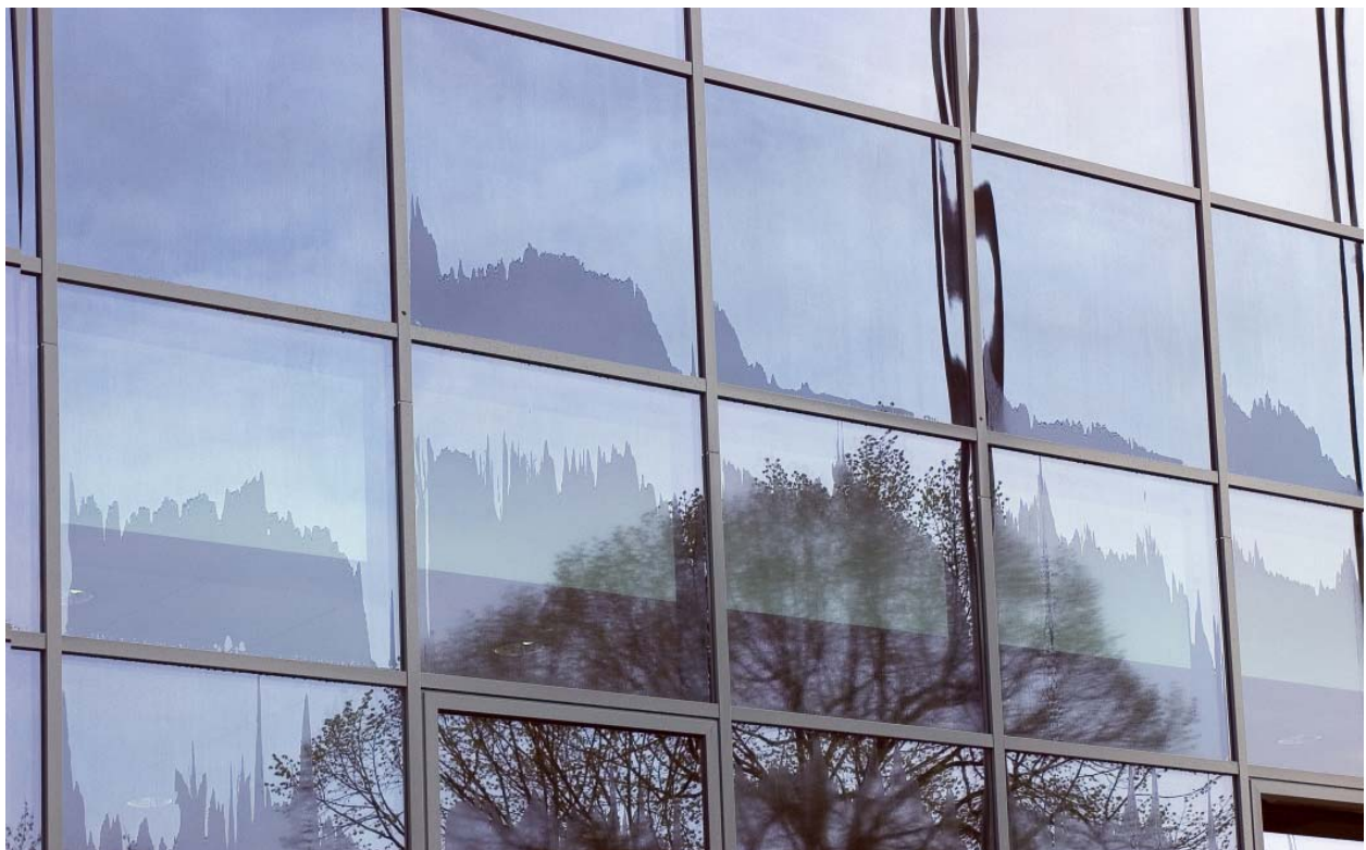
Bild 13 Verglasungen mit hydrophiler, fotokatalytischer Beschichtung trocknen nach einem Regenschauer schnell ab. Es bleiben keine Tropfenränder zurück.
