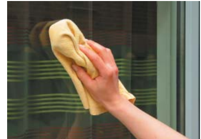
Bild 19, 20 und 21 Bei der Reinigung von Gläsern mit fotokatalytischer Beschichtung auf der Außenseite dürfen keine scheuernden oder kratzenden Hilfsmittel eingesetzt werden. Klares Wasser und einen Schwamm bzw. ein weiches Tuch und handelsübliche neutrale Glasreinigungsmittel empfehlen die Hersteller.
