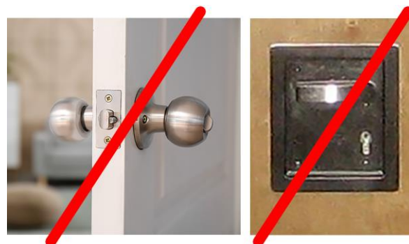
Bild 3 Türknauf oder eingelassener Türgriff sind für motorisch eingeschränkte Menschen schwer bedienbar und somit ungeeignet (Quelle linkes Bild: AdobeStock_420666362_©_Pixel-Shot; Quelle rechtes Bild: ift Rosenheim)
