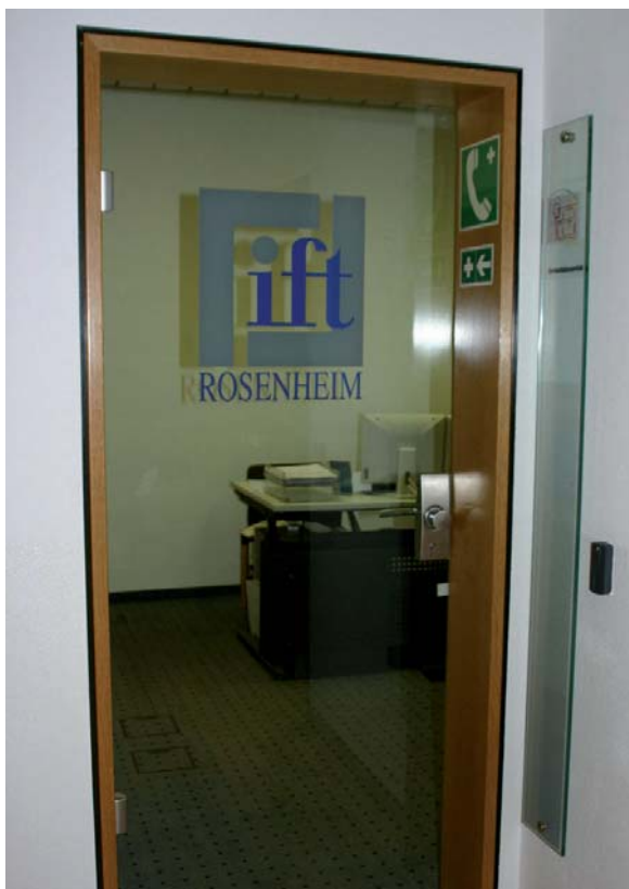
Bild 1 Ganzglastür im oberen Drittel bedruckt (Eingang ift Kommunikationszentrale)
