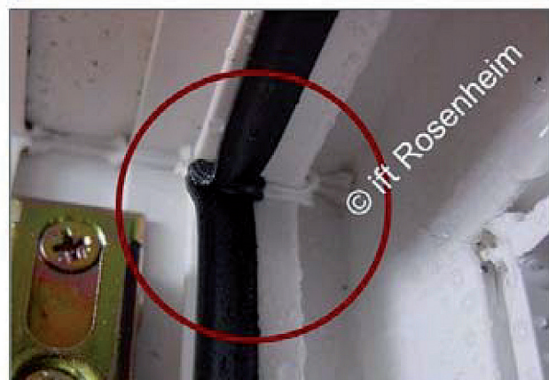
Bild 1 Typische sichtbare Verarbeitungsfehler und Qualitätsmängel von Fenstern mit Einfluss auf die Dichtigkeit
