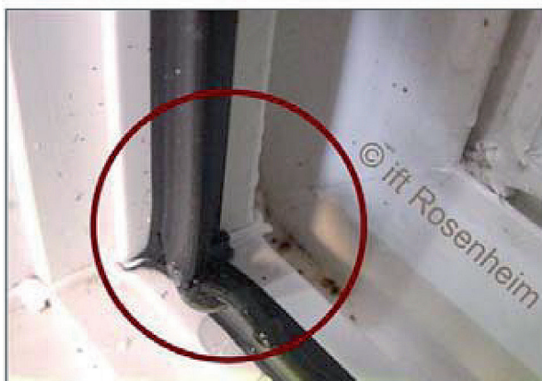
Bild 1 Typische sichtbare Verarbeitungsfehler und Qualitätsmängel von Fenstern mit Einfluss auf die Dichtigkeit
