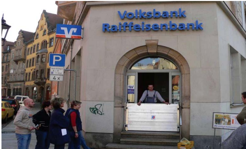
Bild 11 Temporäre Schutzmaßnahmen für Türen oder großformatige Fenster
